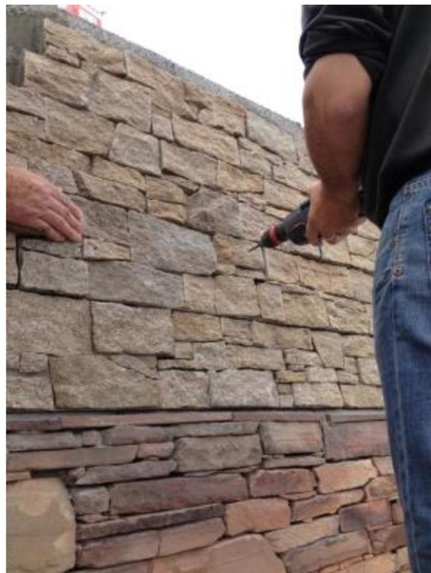
**Figure 15f - Perçage du support**
