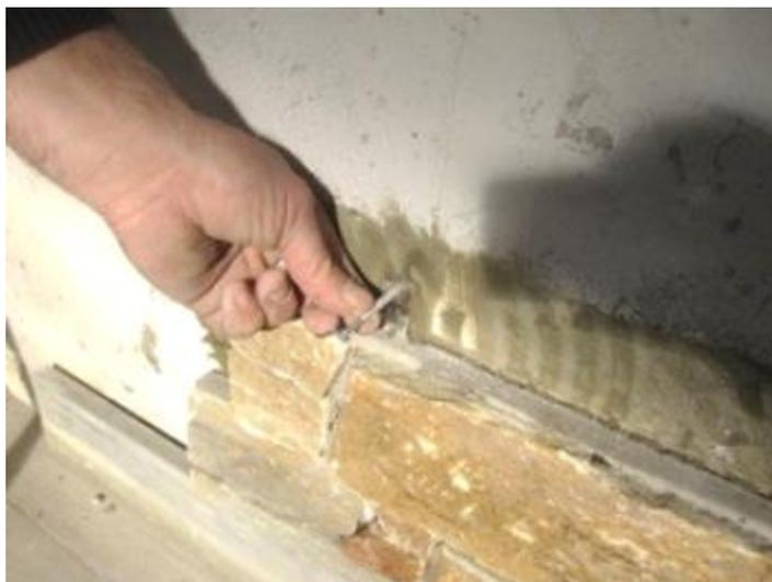
**Figure 8c - Mise en œuvre des chevilles de fixation**
