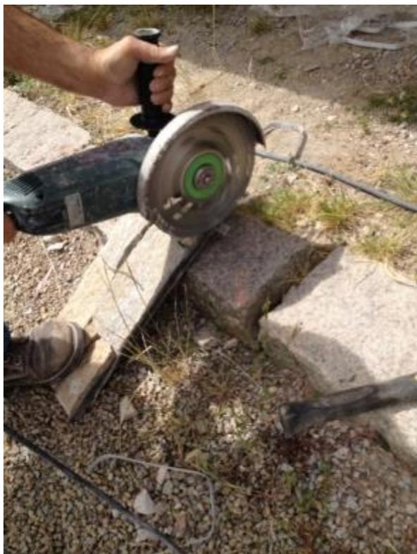
**Figure 15a - Sciage de la pâte de fixation**
