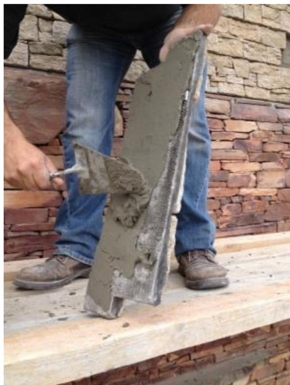
**Figure 15d - Encollage au dos du panneau Happyclad**
