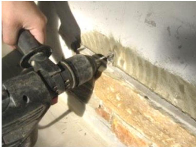
**Figure 8b - perçage pour les fixations**
