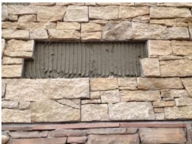
**Figure 15c - Application de la colle sur le support**
