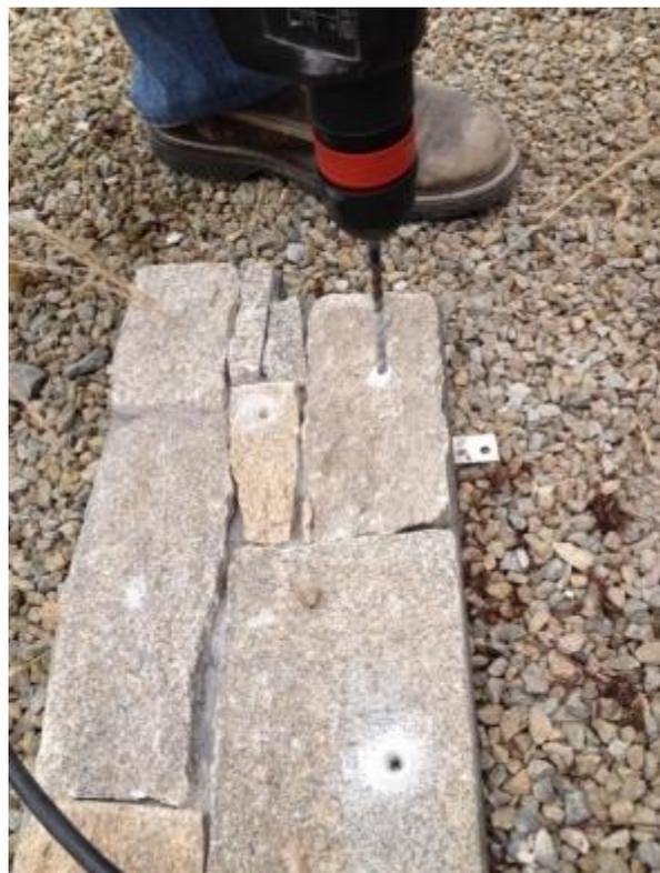
**Figure 15b - perçage de trous dans la pierre**
